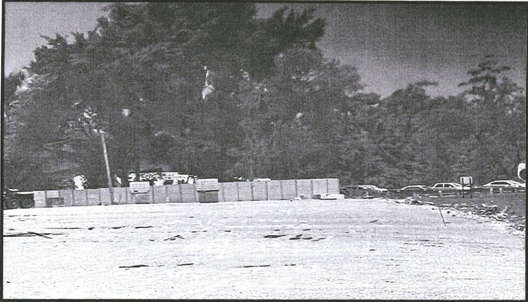
Vista parcial do terreno e do muro em construção
