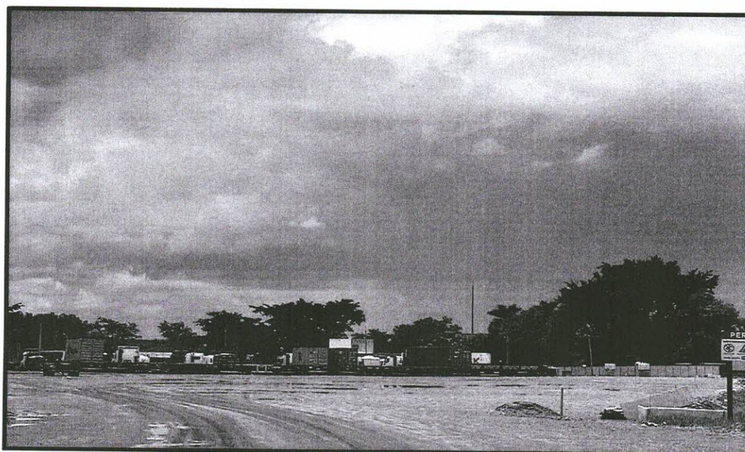
Vista parcial do terreno e do muro em construção
